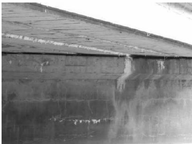
Zatékání z nosníků na podpěru.
